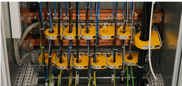
*Differenzstromüberwachung von Endstromkreisen und Abgängen*
